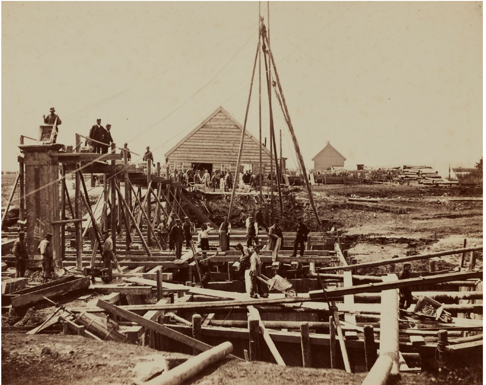
Heimachines aan het werk voor de fundering van het Beijerinckgemaal (NL-RtSA_4187_XXXIII-80-02-1)
