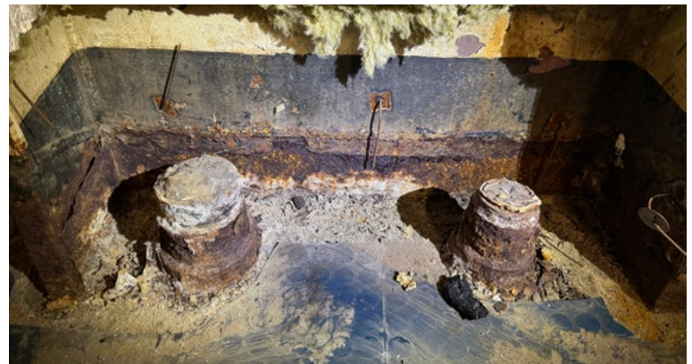
waterlijn geeft condens en dus roest
