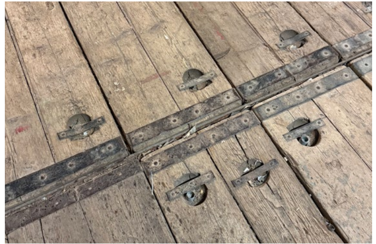
originele balken voor vloer in ruim - zo werd alle vracht opgestapeld per vloer
