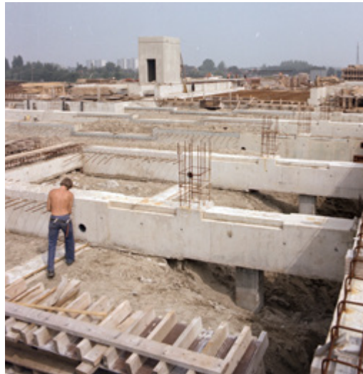
Bouw van het metrostation Capelsebrug, 1980 (Stadsarchief Rotterdam)
