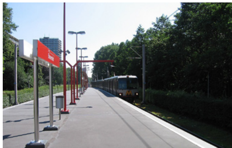
Metrostation Binnenhof met een metro van de eerste generatie (foto wikipedia)
